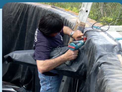
Saldatura dell'attacco alla tubazione del troppo pieno.
