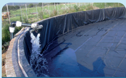
(Sardegna, 2003) La vasca che un tempo presentava molte perdite, è ora pronta per ricevere di nuovo l'acqua dal tubo di adduzione, dopo essere stata impermeabilizzata con liner preformati presaldati e sagomati in fabbrica.
