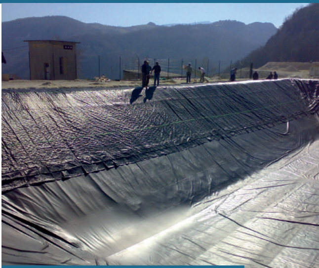
Il telo di protezione sponde, fissato nelle trincee anch'esso, ricopre il telone impermeabile per circa tre quarti della sponda, al fine di permettere il camminamento sui bordi e garantire un'adeguata protezione dai raggi UV, in maniera tale da allungare sensibilmente la durata utile dell'impermeabilizzazione. Si tratta di polipropilene intrecciato, nome commerciale Genatex 700.
