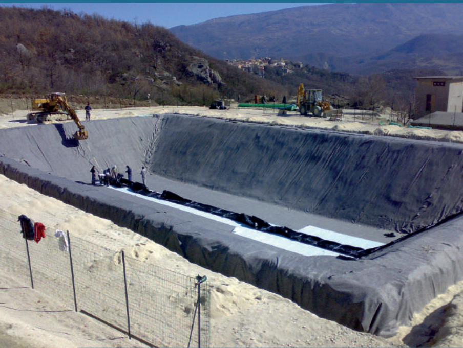
(Chieti, 2008) Dopo aver steso il tessuto non tessuto ed averlo risvoltato nelle trincee perimetrali, il telo impermeabile viene tirato sulla lunghezza del lagone, grazie anche all'ausilio dei mezzi meccanici. Disporre in loco di una gru o una ruspa con braccio meccanico limita la necessità di uomini per le operazioni di posa in opera.
