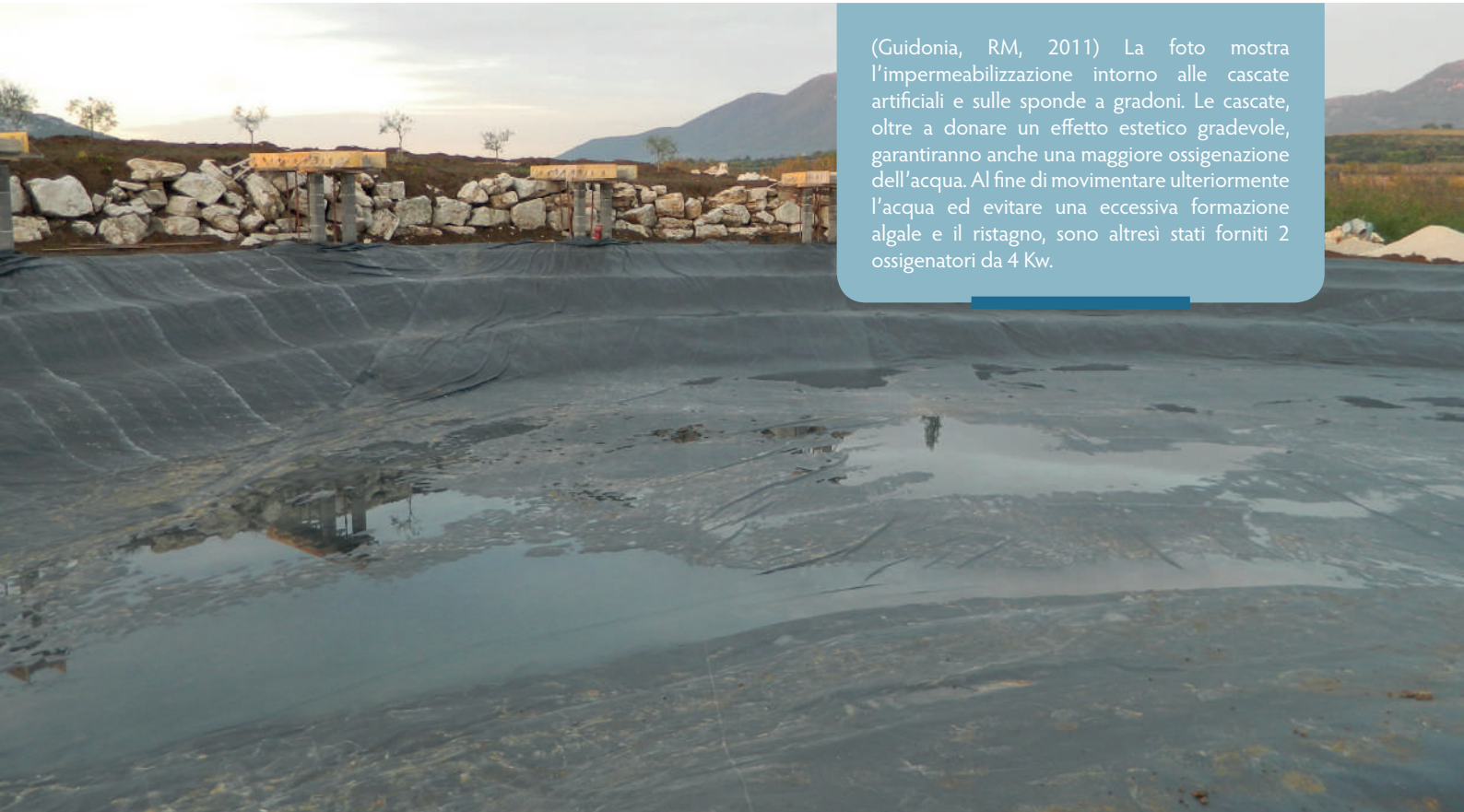
(Lanuvio, RM, 2014) Quando possibile, come in questo caso grazie ad una forma rettangolare, è molto più conveniente che i teli impermeabili siano presaldati in fabbrica in un solo pezzo. Le saldature comportano una piccola spesa in più in termini di costi dei materiali, ma un enorme risparmio in termini di tempo e dunque manodopera (ben più costosa). Risulta pertanto agevole stendere la guaina impermeabile preformata in un giorno lavorativo. Non solo: la qualità delle saldature realizzate in fabbrica, non è minimamente paragonabile a quella delle saldature a mano poste in loco.
