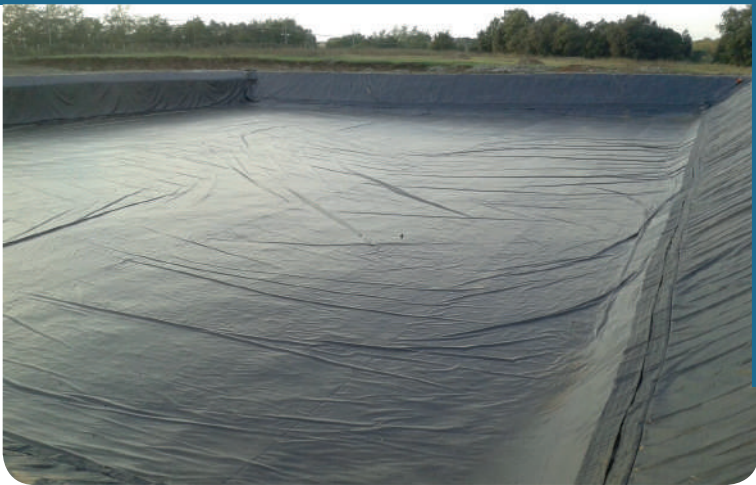
(Lanuvio, RM, 2014) Ecco come si presenta il lago artificiale al termine delle operazioni di impermeabilizzazione con i liner: in basso a destra possiamo notare le tasche della rete di protezione degli argini. Il risultato è eccellente, eppure la posa in opera è stata eseguita dal cliente e dai suoi assistenti: la ditta Benza ha fornito solo i materiali. Questo lascia intendere quanto sia conveniente ordinare un liner presaldato, anziché eseguire le saldature in loco mediante l'ausilio di tecnici specializzati.
