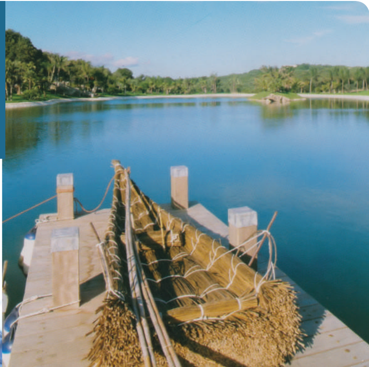
Direste mai che il telo impiegato per l'impermeabilizzazione è di colore nero? Questa foto fugge ogni dubbio sulla non esigenza di teli da piscina azzurri, blu o verdi o colorati in generale, sia per ciò che concerne il fondo del lago, sia per ciò che riguarda le sponde, che appaiono bianche, grazie alla naturalizzazione con la sabbia. Il telo nero presenta inoltre il vantaggio di una minor sporchevolezza.
