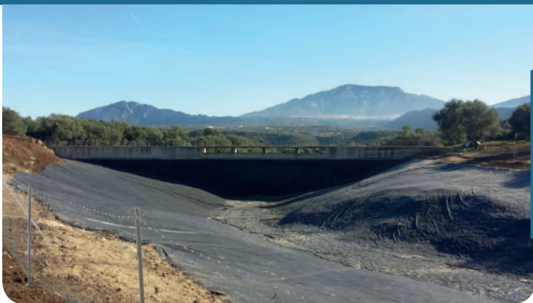
(Sardegna, 2015) Diga di 60 metri di larghezza circa e 7 metri di altezza circa nel punto massimo, impermeabilizzata in EPDM. Anche il fiume che porta al muro della diga è stato reso impermeabile. Al centro della base del muro si trova il pozzetto di scarico.
