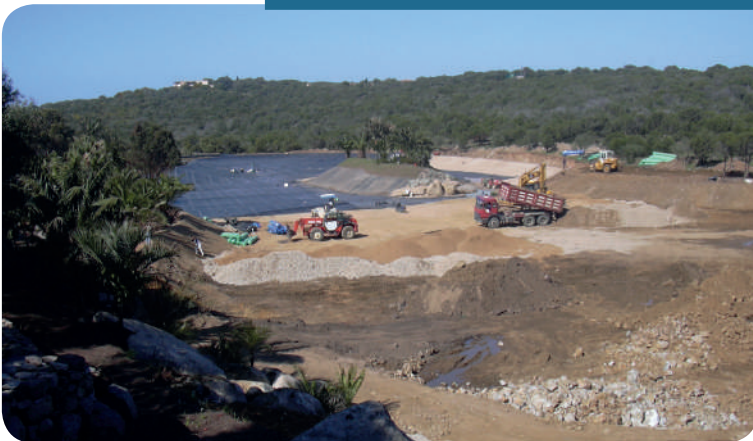
Preparazione dello scavo e livellamento del terreno mediante l'ausilio di mezzi meccanici quali gru, ruspe, camion. A questo punto del lavoro, l'impermeabilizzazione del lago artificiale era completata per quasi la metà della superficie totale.
