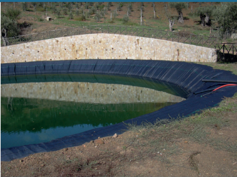
(Castellbuono, Sicilia, 2003) Il telo che si vede in questa foto non è quello impermeabile, bensì la rete di protezione delle sponde che favorisce il camminamento sui bordi nonché la fuoriuscita di animali selvatici e garantisce un'adeguata resistenza ai raggi UV.
