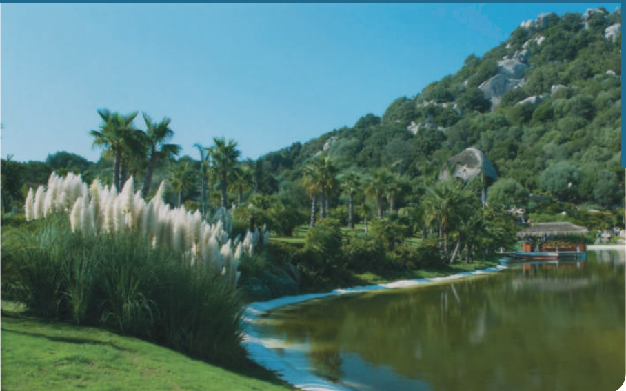
Visuale laterale del lago artificiale completato. Si può notare la naturalizzazione con sabbia bianca attaccata alla guaina mediante appositi collanti: il telo nero è "svanito", non si vede più e resta solo un magnifico effetto da spiaggia bianca caraibica.
