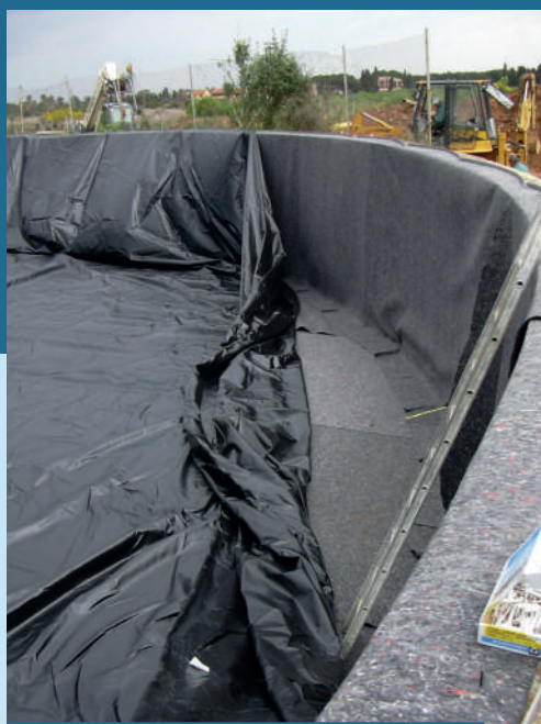
Il telone impermeabile presaldato e preformato in fabbrica viene tirato e posato sopra al tessuto protettivo.
