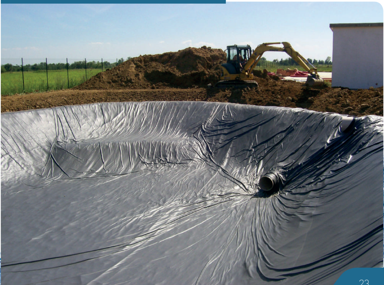
(Santhià, VC, 2009) Nella foto di questo lago per lo stoccaggio d'acqua antincendio è possibile notare il tubo di aspirazione delle pompe. Il lago ha una forma ovale e anche alcuni gradoni: ciò lascia intendere che sia possibile impermeabilizzare qualsiasi forma e dimensione. Le pieghe nei teli non causano alcun problema: il telo era stato saldato in fabbrica, in forma rettangolare, mentre gli attacchi per le tubazioni erano state realizzate in loco da ns. tecnici specializzati.
