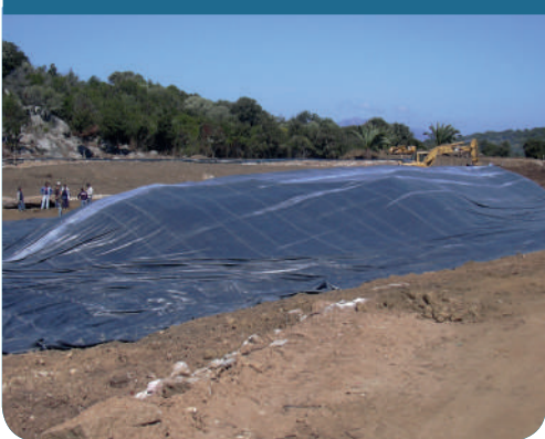
Impermeabilizzazione di un isolotto di circa 50 metri di lunghezza x 15 metri di larghezza, con un'altezza di 4 metri, creato artificialmente, riportando la terra al centro del lago.
