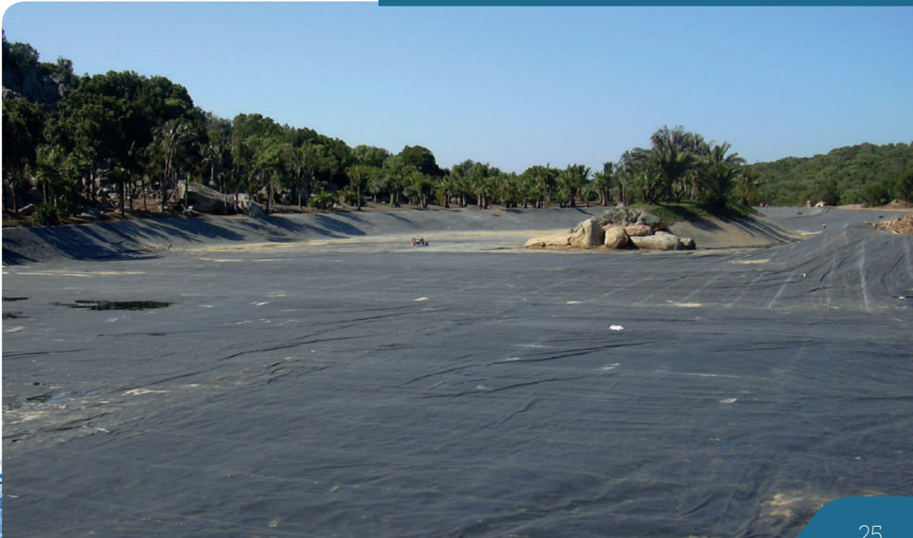
Per poter posare tonnellate di massi sul telo impermeabile in "Firestone EPDM" da 1,02 mm, senza rischiare rotture o perforazioni, sono stati impiegati sabbia e geotessuto non tessuto in modo tale che la guaina impermeabile in gomma rimanesse protetta sopra e sotto "a sandwich".
