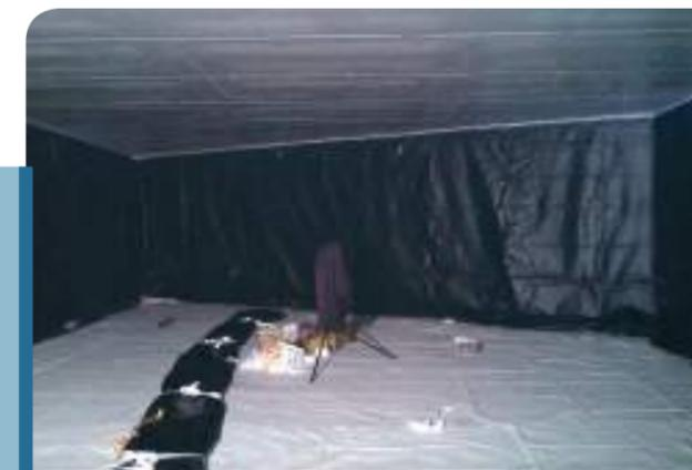
E' possibile saldare a caldo sia il PVC sia il polipropilene, così come il polietilene e altri materiali, mentre l'EPDM va vulcanizzato a freddo, utilizzando un primer. Per far passare il telo attraverso la botola, senza doverla spaccare, è stato deciso di eseguire la saldatura sul posto, infatti si può notare il telo di fondo arrotolato, proprio per questa ragione.
