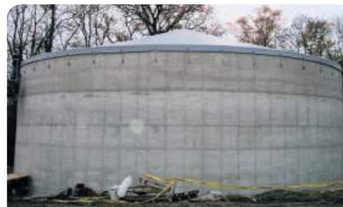
Copertura impermeabile con palo centrale, tipo "tendone da circo".
