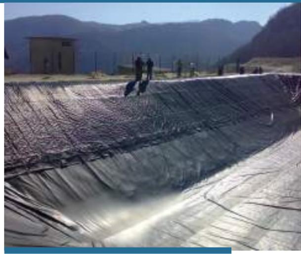
Il telo di protezione sponde, fissato nelle trincee anch'esso, ricopre il telone impermeabile per circa tre quarti della sponda, al fine di permettere il camminamento sui bordi e garantire un'adeguata protezione dai raggi UV, in maniera tale da allungare sensibilmente la durata utile dell'impermeabilizzazione. Si tratta di polipropilene intrecciato, nome commerciale Genatex 700.
