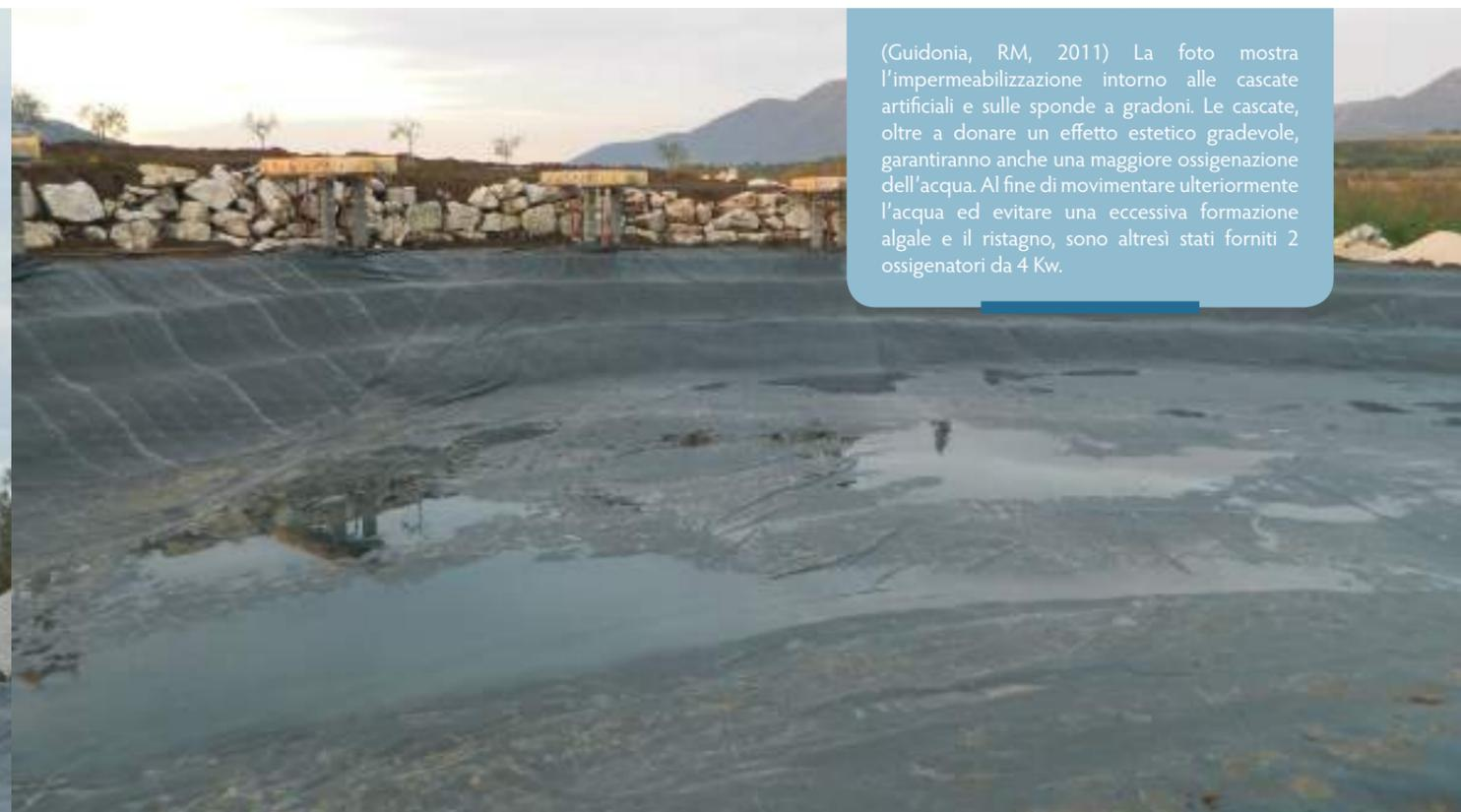
(Guidonia, RM, 2011) La foto mostra l'impermeabilizzazione intorno alle cascate artificiali e sulle sponde a gradoni. Le cascate, oltre a donare un effetto estetico gradevole, garantiranno anche una maggiore ossigenazione dell'acqua. Al fine di movimentare ulteriormente l'acqua ed evitare una eccessiva formazione algale e il ristagno, sono altresì stati forniti 2 ossigenatori da 4 Kw.
