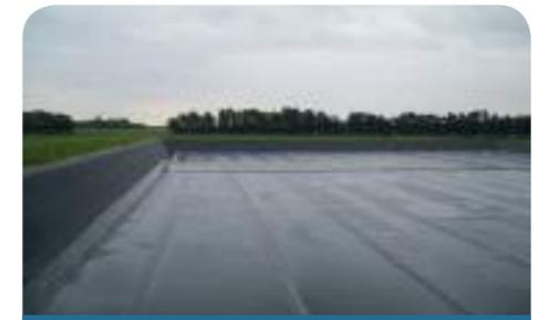
Le coperture per laghi artificiali galleggianti hanno il pregio di poter essere realizzate anche in grandi misure, oltre i 20 metri di larghezza, per laghi di qualsiasi dimensione. Il telone galleggiante sale e scende con il livello dell'acqua in vasca e viene mantenuto al centro dalle corde elastiche; quando il lago è vuoto, si appoggia sul fondo. A seconda dei casi, si tratta proprio dello stesso liner in polipropilene utilizzato per il fondo.
