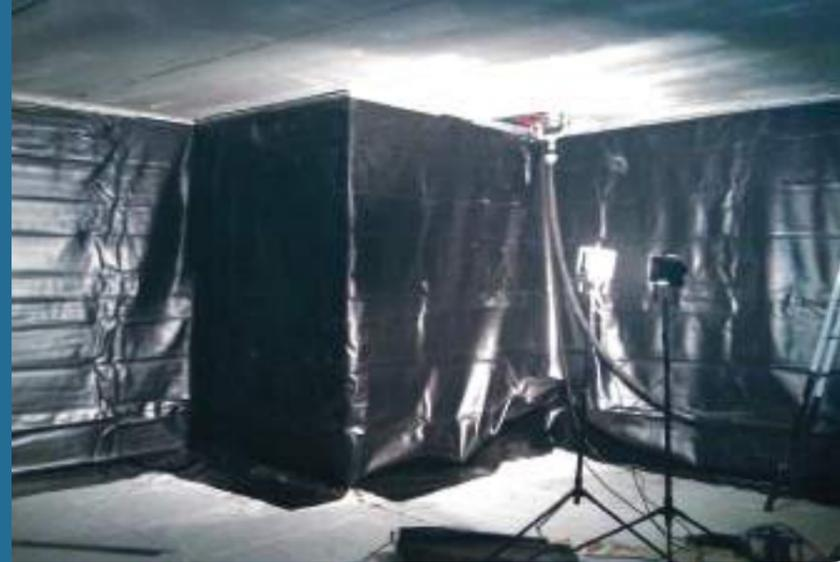
(Imperia, 2014) Si può impermeabilizzare qualsiasi forma e dimensione: anche se ci sono angoli e spigoli, è possibile adattare le guaine impermeabili alla sagoma della vasca, senza alcun problema. Sussiste altresì la possibilità di eseguire riparazioni di cisterne sotterranee o interrate in cemento, come in queste foto.
