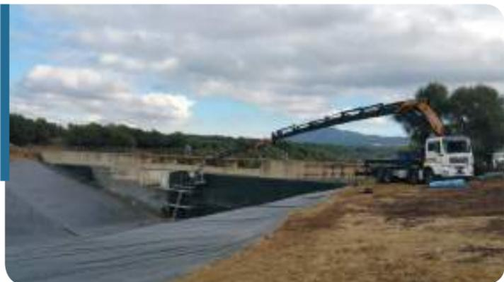
La sola colla per EPDM non sarebbe stata ovviamente sufficiente per reggere il peso del telo impermeabile: 1,25 Kg al mq. Per questo motivo, lo abbiamo fissato sulla cima anche mediante barre d'acciaio preforate ogni 10 cm. Nella foto, l'installatore specializzato sta trapanando il muro attraverso il foro nella bandella d'acciaio, per poi poter inserire appositi tasselli a battere.
