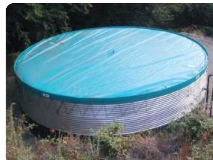
(Bagno a Ripoli, Firenze, 2011) Vasca per acqua potabile, GenaflexStore®, piena. Questo modello chiuso è costituito da una sorta di "palloncino" che si gonfia e sgonfia, seguendo l'andamento del livello interno dell'acqua. Nella foto è stato raggiunto il livello di massimo riempimento; è possibile notare, sulla destra, i tubi per il troppo pieno e, al centro del tetto in PVC della vasca, la valvola di sfianto aria.
