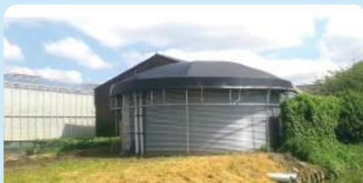
(Olanda, 2016) Ecco una prima installazione della copertura Stand-Alone. E' possibile coprire la vasca con questo metodo anche in un secondo momento, in quanto la struttura è completamente indipendente da quella del serbatoio.
