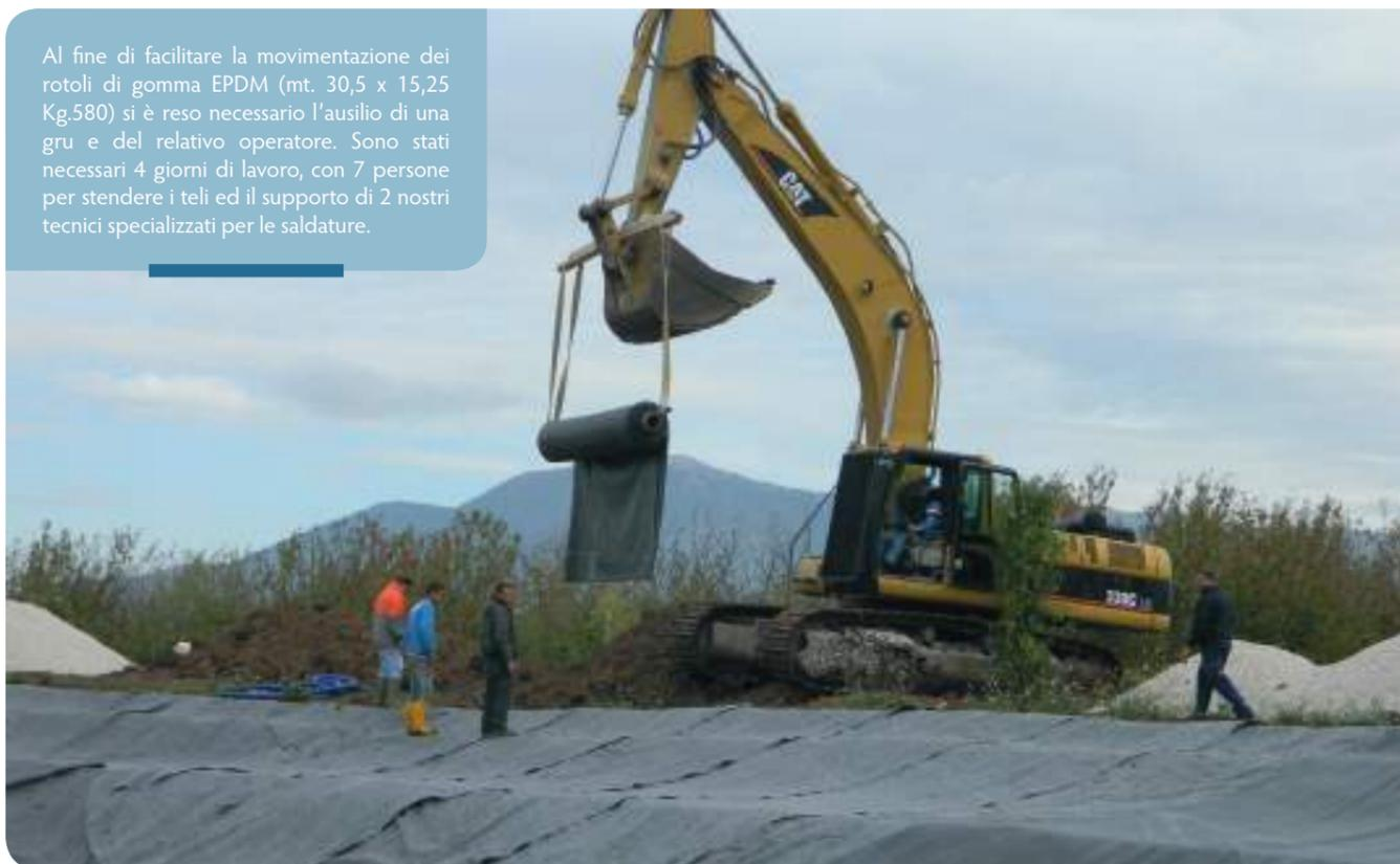
Al fine di facilitare la movimentazione dei rotoli di gomma EPDM (mt. 30,5 x 15,25 Kg.580) si è reso necessario l'ausilio di una gru e del relativo operatore. Sono stati necessari 4 giorni di lavoro, con 7 persone per stendere i teli ed il supporto di 2 nostri tecnici specializzati per le saldature.
