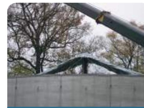
Il telone di copertura viene posato con la gru sopra al palo e poi srotolato per poggiare sui cavi di sostegno.
