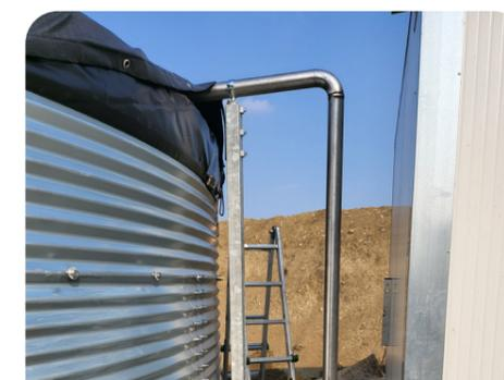
(Lodi, 2022) Tubazione di ritorno in vasca per asametro, sorretta da un palo di supporto. Rispetto al foro nella lamiera, una soluzione più semplice è costituita dal passaggio del tubo dall'alto, ma sotto alla copertura in rete, alla quale sono stati sfilati un paio di elastici. Non bisogna lasciare appoggiare le tubazioni direttamente sulle lamiere in cima.
