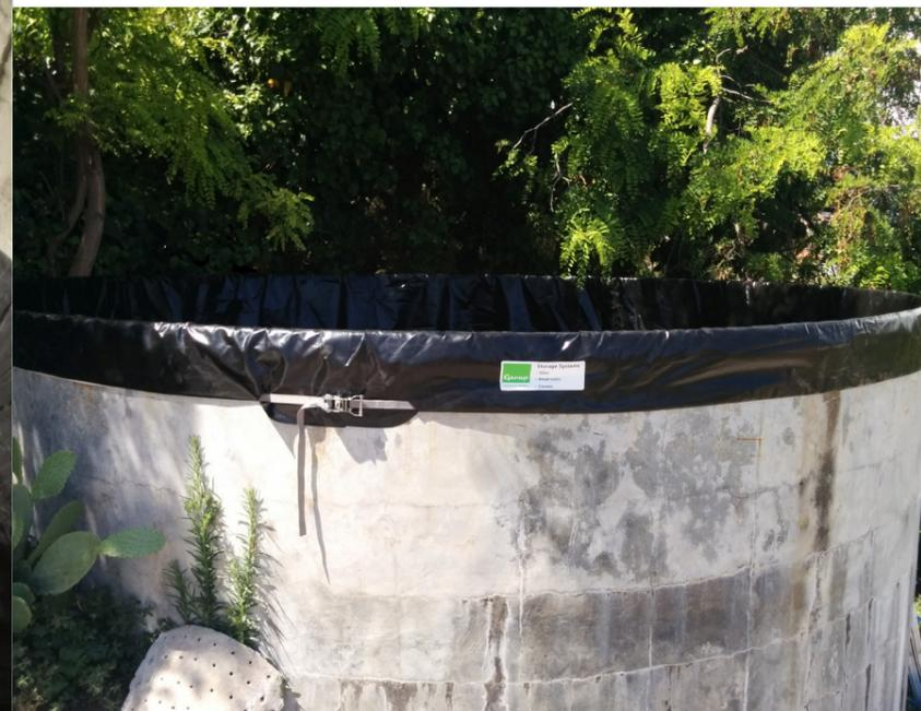
(Val d'Aosta, 2021) Impermeabilizzazione in EPDM di una vasca in cemento sotterranea. La cisterna interrata verrà riempita con l'acqua piovana raccolta dal tetto e per l'aspirazione dell'impianto di irrigazione verrà impiegata una pompa sommersa.
