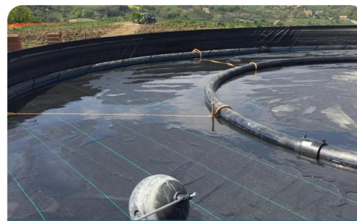
(Battipaglia, SA, 2019) Di norma, le tubazioni delle coperture flottanti vengono installate soltanto sotto alle coperture stesse per favorirne il galleggiamento. In questo caso particolare, invece, sono state legate anche sopra con le corde, per garantire maggiore stabilità in caso di forti venti, quando il serbatoio è al colmo.
