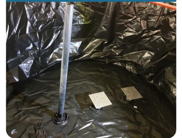
(Zaniga, provincia di Bergamo, 2020) Installazione al coperto di un serbatoio antincendio da 90 metri cubi utili, per un impianto sportivo.
