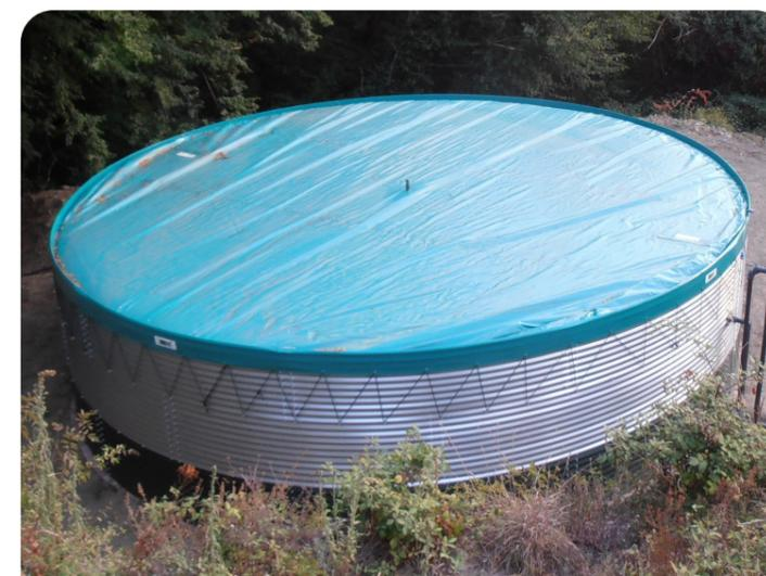
(Bagno a Ripoli, Firenze, 2011) Vasca per acqua potabile, GenaflexStore®, piena. Questo modello chiuso è costituito da una sorta di "palloncino" che si gonfia e sgonfia, seguendo l'andamento del livello interno dell'acqua. Nella foto è stato raggiunto il livello di massimo riempimento; è possibile notare, sulla destra, i tubi per il troppo pieno e, al centro del tetto in PVC della vasca, la valvola di sfiato aria. Trattasi di serbatoio non in pressione.
