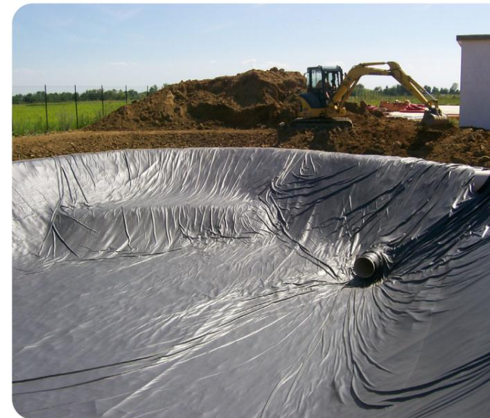
(Santhià, VC, 2009) Nella foto di questo lago per lo stoccaggio d'acqua antincendio è possibile notare il tubo di aspirazione delle pompe. Il lago ha una forma ovale e anche alcuni gradoni: ciò lascia intendere che sia possibile impermeabilizzare qualsiasi forma e dimensione. Le pieghe nei teli non causano alcun problema: il telo era stato saldato in fabbrica, in forma rettangolare, mentre gli attacchi per le tubazioni erano state realizzate in loco da ns. tecnici specializzati.
