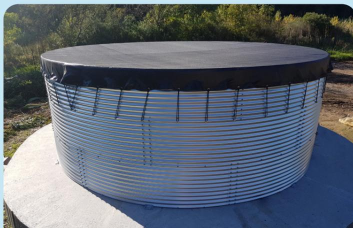
(Andora, provincia di Savona, 2019) Rete di copertura antialghe in tensione, dotata di sole ed elastici per il fissaggio alle rondelle supplementari posizionate sui bulloni delle lamiere.
