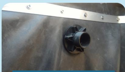
(Isola del Giglio, 2018) Le bandelle d'acciaio tassellate alla parete sorreggono il telo impermeabile. Il "Tradux" è costituito da una doppia vite di plastica dotata di guarnizione; in questo caso svolgeva una mera funzione di troppo pieno. Può essere altresì impiegato quale passante per tubi fino a 2" o anche per il passaggio di filo elettrico, mediante l'applicazione di apposito pressacavo fornito in dotazione.
