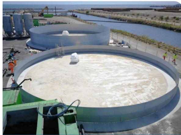
Le lamiere che formano i cilindri d'acciaio delle 2 cisterne sono state poggiate su 2 cordoli di cemento armato, riempiti all'interno con sabbia fine, per ridurre la spesa rispetto a una platea intera.
