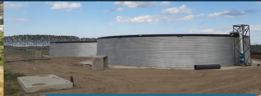
(Lagosanto, provincia di Ferrara, 2021) Due vasche irrigue di accumulo per un'azienda agricola vivaistica, per l'irrigazione delle serre e la rimoltiplicazione delle piante di kiwi. Entrambe hanno un'altezza di 3,12 metri e diametro 20,03 metri e un volume di quasi un milione di litri cadauna.
