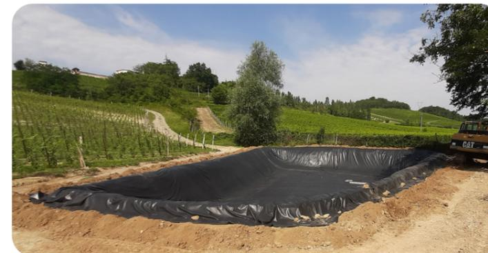
(Novi Ligure, Piemonte, 2019) Lago destinato allo stoccaggio di acqua irrigua per i vigneti retrostanti, scavato in terra e impermeabilizzato mediante una guaina in caucciù sintetico (gomma EPDM) resistente ai raggi UV, all'allungamento fino al 300% e alle basse temperature fino a -45°C.
