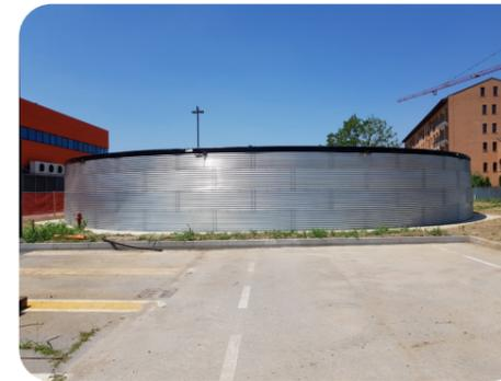
(Iglesias, Sardegna, 2015) Questo serbatoio antincendio ha un'altezza di 4,64 metri: la massima possibile. La cisterna prefabbricata di diametro 7,28 metri comprendeva 5 attacchi presaldati sul fondo del telo impermeabile, collegati alle tubazioni annegate nella platea di cemento armato: aspirazione elettropompa e motopompa, svuotamento, troppo pieno, valvola a galleggiante, indicatore di livello.
