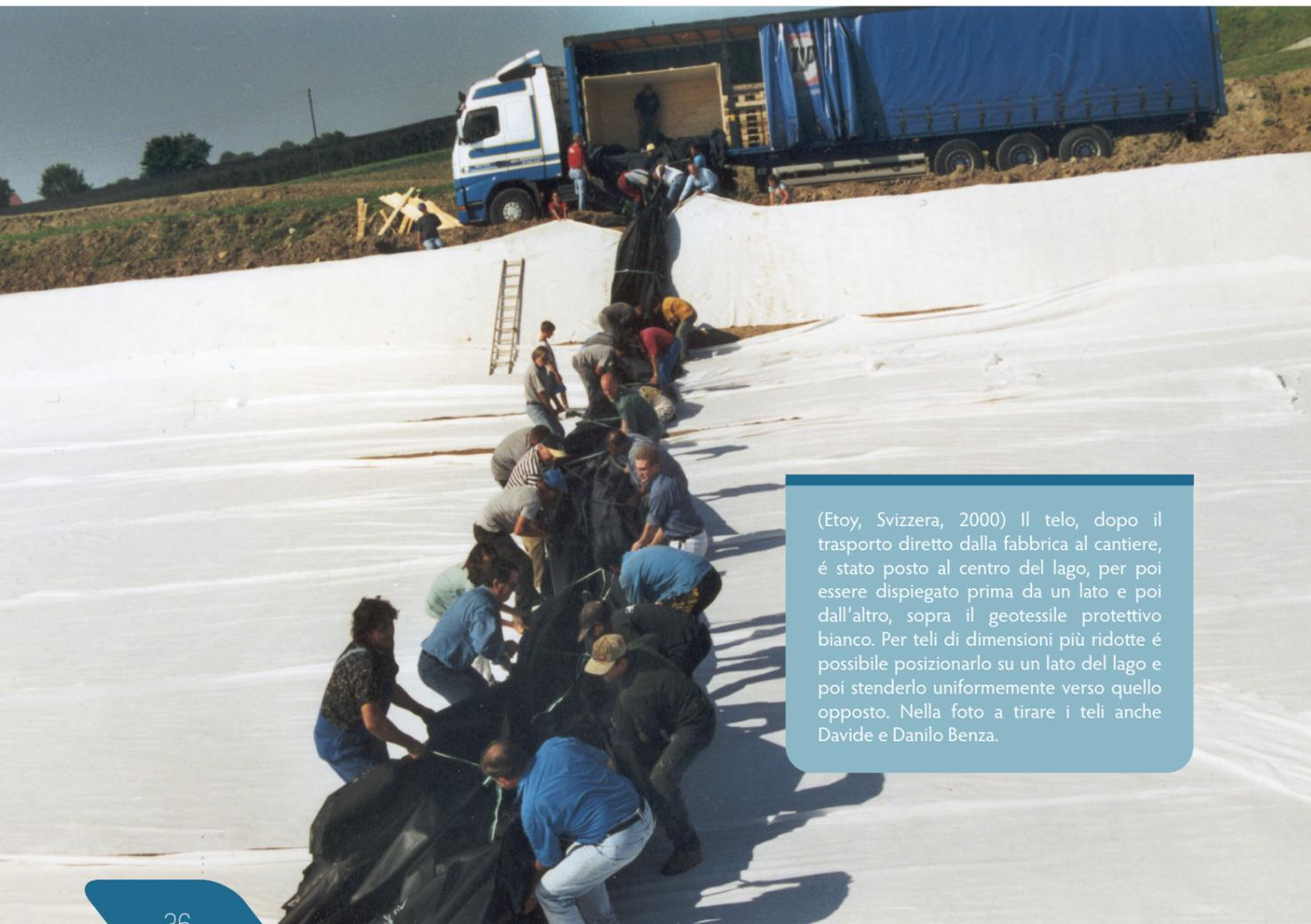
(Etoy, Svizzera, 2000) Il telo, dopo il trasporto diretto dalla fabbrica al cantiere, è stato posto al centro del lago, per poi essere dispiegato prima da un lato e poi dall'altro, sopra il geotessile protettivo bianco. Per teli di dimensioni più ridotte è possibile posizionarlo su un lato del lago e poi stenderlo uniformemente verso quello opposto. Nella foto a tirare i teli anche Davide e Danilo Benza.
