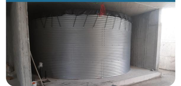
(Lodi, 2022) Serbatoio antincendio e relativo box con gruppo pompe, posati su una platea antisismica di cemento armato. Le due aspirazioni DN110 mm. di acciaio saldate in loco passano sotto alla cisterna, mentre la tubazione per il controllo di flusso rientra in vasca, sorretta da un palo ancorato a terra, tra la copertura e la lamiera superiore.
