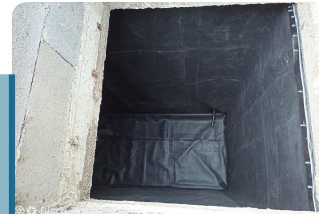
La botola d'accesso alla fine dei lavori di impermeabilizzazione, con il telo fissato fino ai bordi mediante tasselli e bandelle. Per questa tipologia di lavorazioni è necessario personale qualificato, dotato di apposito patentino per lavori in spazi confinati e relativa attrezzatura.
