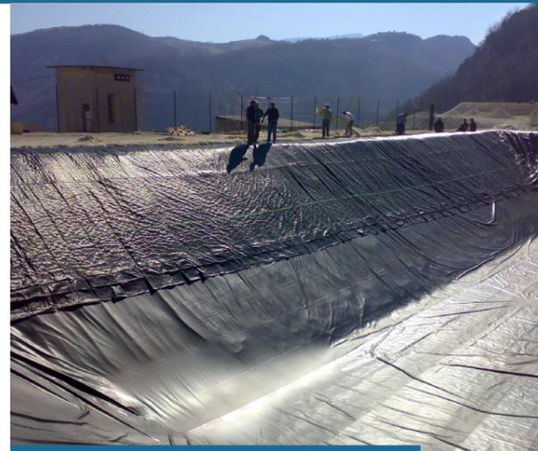
Il telo di protezione sponde, fissato nelle trincee anch'esso, ricopre il telo impermeabile per circa tre quarti della sponda, al fine di permettere il camminamento sui bordi e garantire un'adeguata protezione dai raggi UV, in maniera tale da allungare sensibilmente la durata utile dell'impermeabilizzazione. Si tratta di polipropilene intrecciato, nome commerciale Genatex 700.
