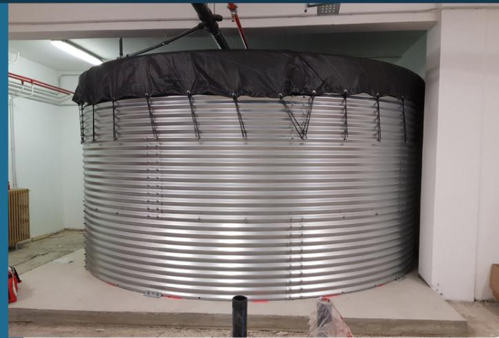
(Torino, 2019) Serbatoio antincendio in acciaio zincato, montato in un piano interrato, poggiato su basamento in cls armato calcolato per essere antisismico. Completo di ogni accessorio: adduzione, svuotamento, troppo pieno, controllo di livello, piastre antivortice, staffe a "L" di ancoraggio a terra, rete di copertura.
