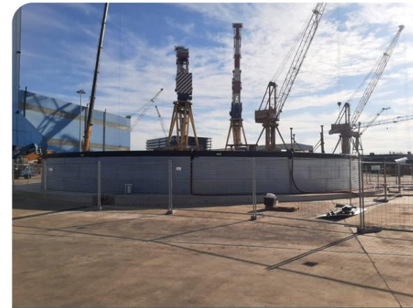
(Marghera, provincia di Venezia, 2021) Cisterna di acciaio misure Ø 27,31 H 2,36 destinata a test di carico e scarico gru in un cantiere navale, poggiate su cordolo di cemento armato e sabbia al centro.
