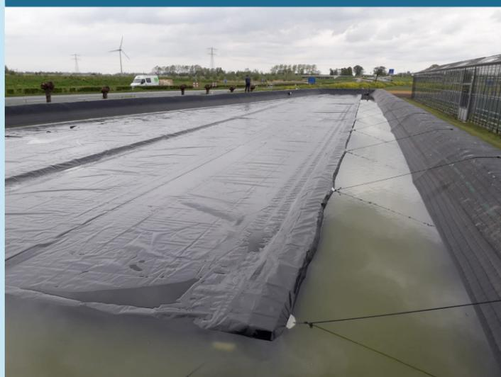
(Naivasha, Kenya) Riserva idrica chiusa per la coltivazione di rose nelle serre retrostanti. Quando una copertura non è sufficiente, al fine di evitare anche l'ingresso dell'acqua piovana nel lago, è possibile chiuderlo completamente, utilizzando non soltanto un telo impermeabile per il fondo, ma anche un telo rinforzato, resistente ai raggi UV e persino compatibile con acqua potabile; la sporcizia si depositerà sopra al telone di copertura e la purezza del contenuto non verrà intaccata.
