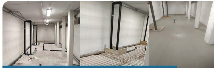
(Segrate, provincia di Milano, 2019) Anche negli scantinati è possibile installare i serbatoi antincendio Genap. Sul pavimento esistente della cantina, sono state predisposte le tubazioni secondo le indicazioni progettuali; in seguito è stata posata la rete elettrosaldata, quindi gettata la platea in calcestruzzo armato.
