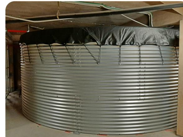
(Livorno, Toscana, 2021) Nello scantinato del palazzo di una nota catena di negozi di abbigliamento, sono stati installati 2 serbatoi: uno per gli idranti e uno per l'impianto sprinkler.
