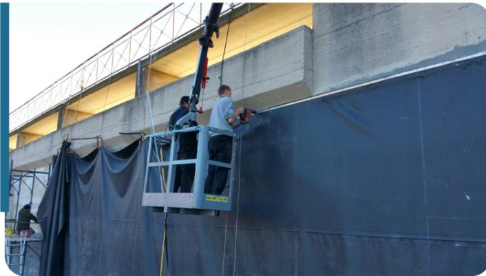
Durante le operazioni di posa in opera di un'impermeabilizzazione, possono servire svariati mezzi meccanici quali gru, manitu, ruspe, e in questo caso specifico, anche una piattaforma mobile con braccio estensibile per raggiungere i punti più in alto della diga e fissare la guaina impermeabile alla parete verticale.
