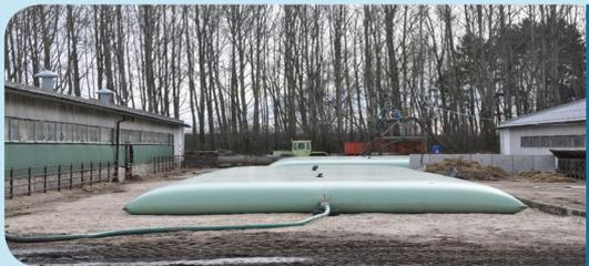
Un'altra valida alternativa, per lo stoccaggio dei liquami zootecnici, può essere costituita dai sacconi chiusi, realizzati in PVC rinforzato da 1300 gr/mq. Dotati di sistema di degassazione, attacchi per le tubazioni di adduzione, scarico e troppo pieno, possono arrivare a volumi fino a 800 metri cubi (8000 quintali). I lagoni interrati, invece, possono arrivare anche fino a 5.000 metri cubi e oltre.
