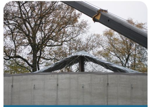
Il telone di copertura viene posato con la gru sopra al palo e poi srotolato per poggiare sui cavi di sostegno.
