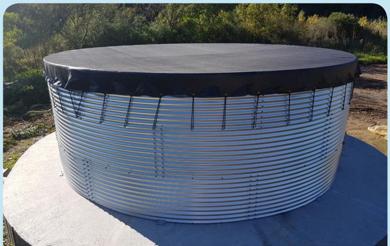
(Andora, provincia di Savona, 2019) Rete di copertura antialghe in tensione, dotata di asole ed elastici per il fissaggio alle rondelle supplementari posizionate sui bulloni delle lamiere.
