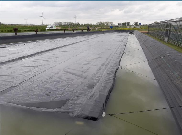
Sui laghi artificiali, ma anche per le vasche prefabbricate in cls, è possibile installare una copertura in tensione, fino a 20 metri di larghezza, lunghezza libera.
