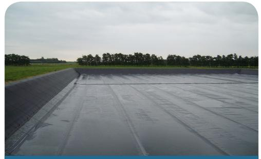
Le coperture per laghi artificiali galleggianti hanno il pregio di poter essere realizzate anche in grandi misure, oltre i 20 metri di larghezza, per laghi di qualsiasi dimensione. Il telone galleggiante sale e scende con il livello dell'acqua in vasca e viene mantenuto al centro dalle corde elastiche; quando il lago è vuoto, si appoggia sul fondo. A seconda dei casi, si tratta proprio dello stesso liner in polipropilene utilizzato per il fondo.
