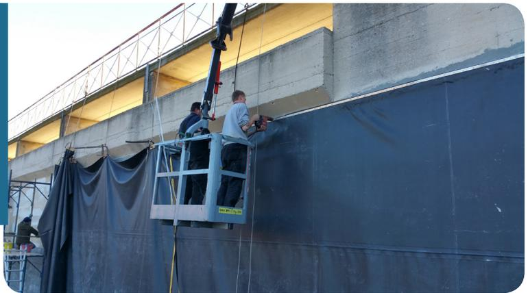
Durante le operazioni di posa in opera di un'impermeabilizzazione, possono servire svariati mezzi meccanici quali gru, manitu, ruspe, e in questo caso specifico, anche una piattaforma mobile con braccio estensibile per raggiungere i punti più in alto della diga e fissare la guaina impermeabile alla parete verticale.
