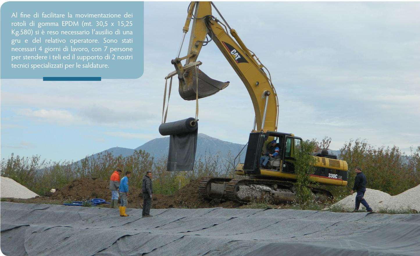
(Guidonia, RM, 2011) La foto mostra l'impermeabilizzazione intorno alle cascate artificiali e sulle sponde a gradoni. Le cascate, oltre a donare un effetto estetico gradevole, garantiranno anche una maggiore ossigenazione dell'acqua. Al fine di movimentare ulteriormente l'acqua ed evitare una eccessiva formazione algale e il ristagno, sono altresì stati forniti 2 ossigenatori da 4 Kw.
