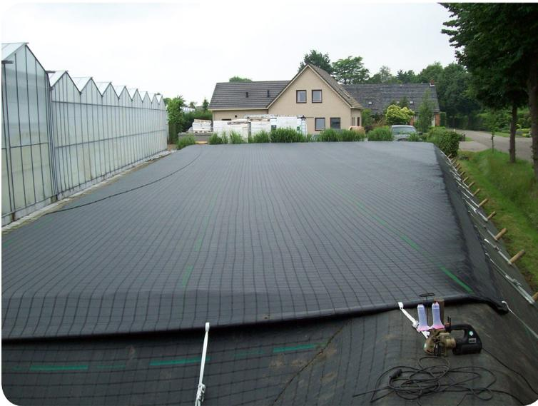
Si possono coprire non soltanto i vasconi interrati, ma anche i laghi artificiali realizzati sopra al livello del cosiddetto "piano di campagna", cioè sopra al piano zero, dunque dotati di argini fuori terra.
