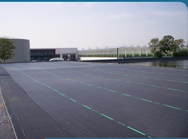
Copertura con telo Genatex per evitare la formazione algale. Trattasi di una rete in polipropilene intrecciata da 190 gr. tesa fra i lati del lago: l'acqua piovana penetra comunque nella riserva idrica sottostante.
