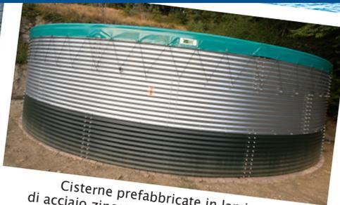
Cisterne prefabbricate in lamiera di acciaio zincato con diametri fino a 31 m e capacità fino a 1.800 m<sup>3</sup>
