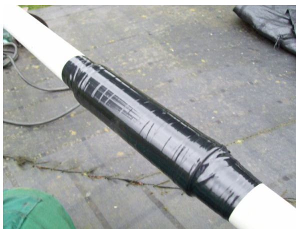
Fig 4. Giunzione tra i tubi
