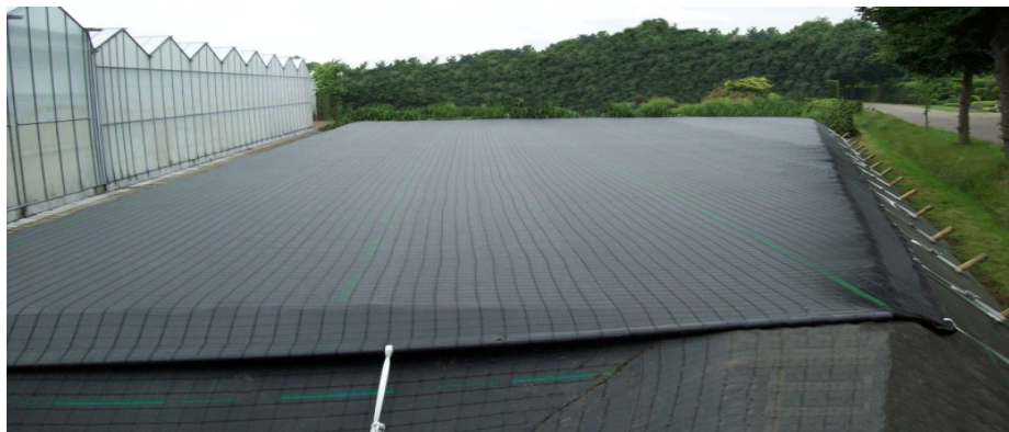
Fig 1. Telo di copertura in tensione su un lagone
