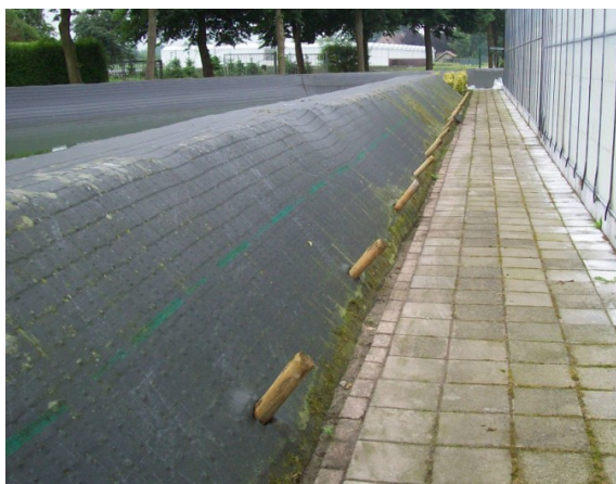
Fig 2. Posizionare i pali
