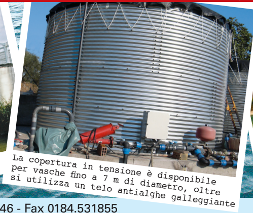
Vasca dotata di lamiera completamente rivestite con una plastificazione in poliuretano
