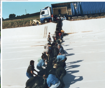
Operazione di stesura dei teli impermeabili
