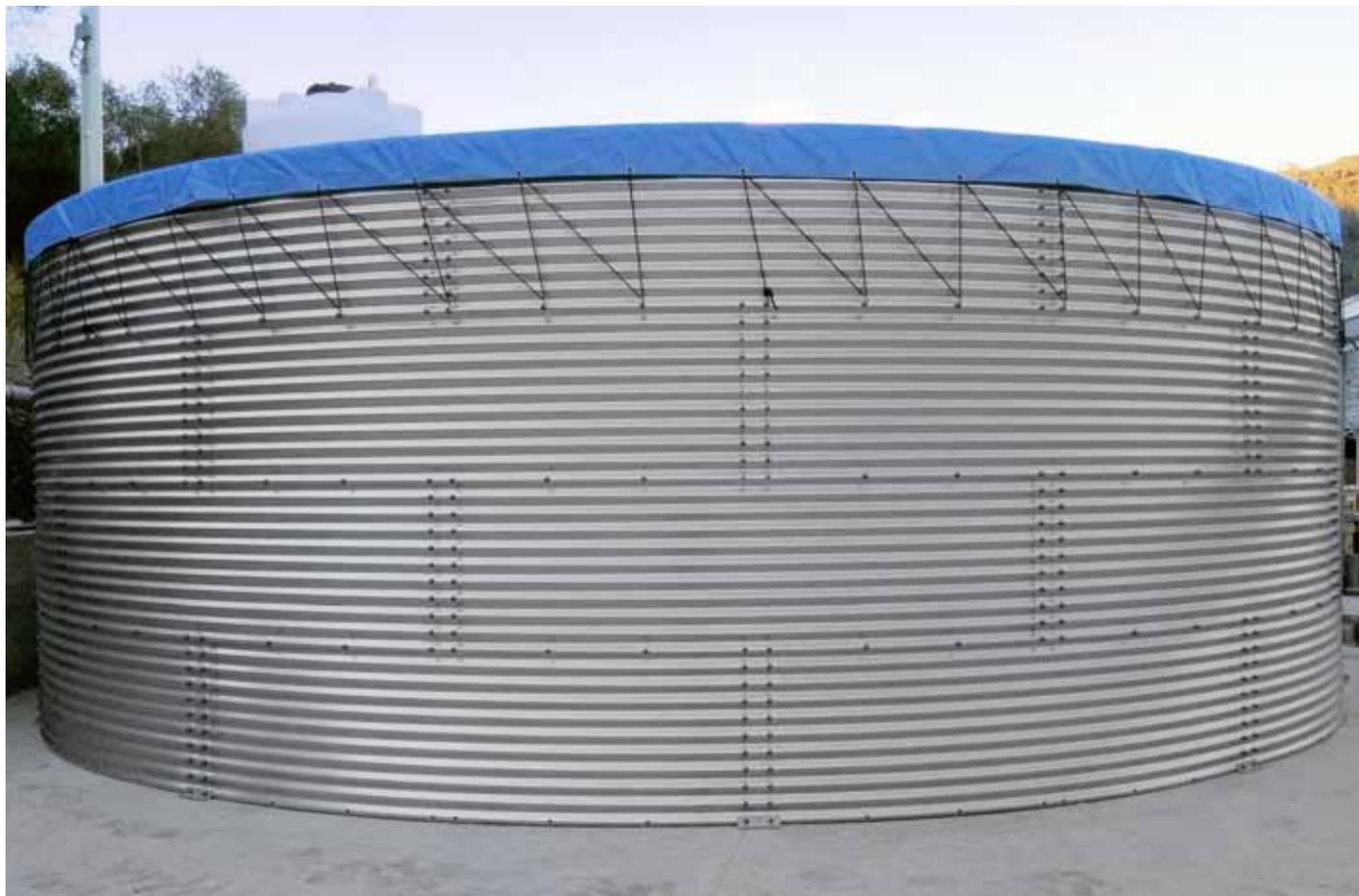
*Silo prefabbricato in lamiera d'acciaio zincato, modello GenaflexStore®. Certificato per acqua potabile. Nella foto in basso a destra è possibile notare il tetto in Pvc, i tubi per lo scarico e il controllo di livello.*
