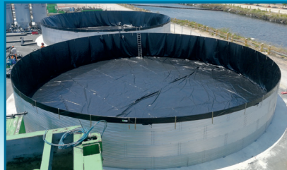
Serbatoi cilindrici componibili in lamiera d'acciaio
