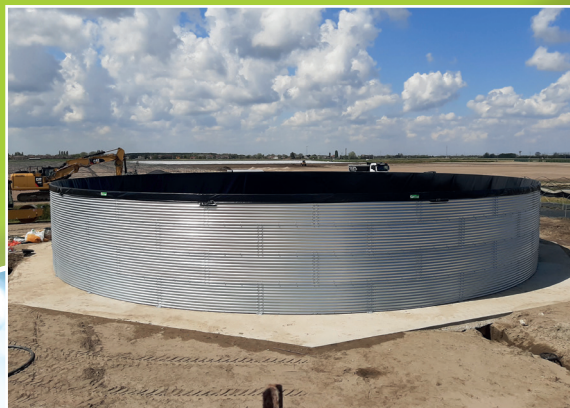
Serbatoi di acciaio per irrigazione e antincendio
