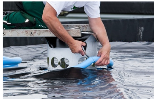
Installatie ring rondschuim / installation foam ring
