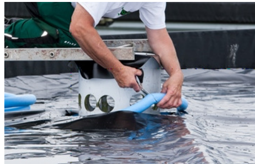
Installatie ring rondschuim / installation foam ring
