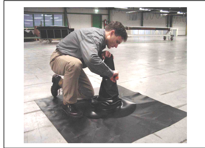
2. Overmaat mouw boven buis wegnippen/wegsnijden Remove surplus of sleeve above pipe by cutting
