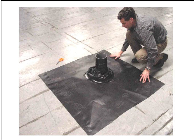
8. Plaats de bodemplaat van de doorvoer onder de foliebekleding Position the bottomplate of the outlet under the lining
