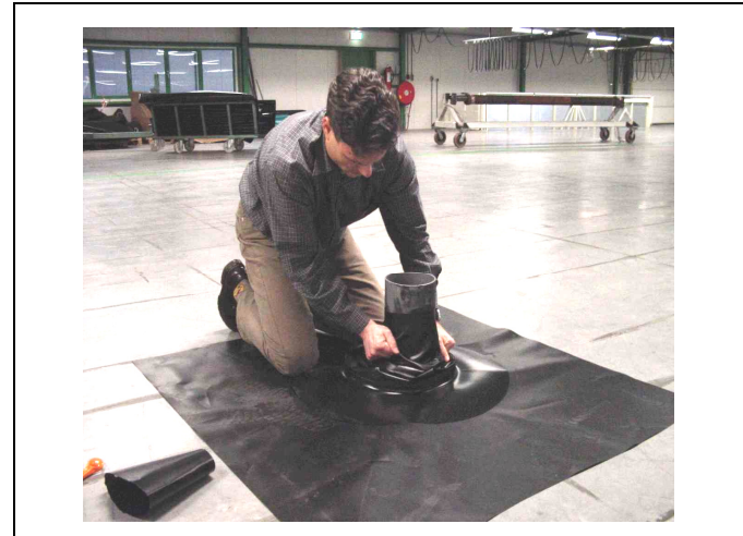
3. Mouw naar onderen schuiven in ploovorm Put sleeve downwards in folds shape
