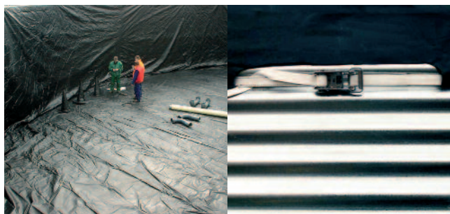
Ancoraggio del rivestimento della cisterna oltre i margini, attraverso un orlo provvisto di un tirante e di fibbie dentellate inossidabili.
