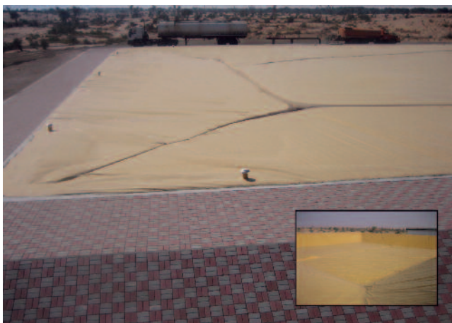
Bacino d'acqua completamente chiuso per lo stoccaggio di acqua per l'irrigazione, Al Ain, Emirati Arabi Uniti.
